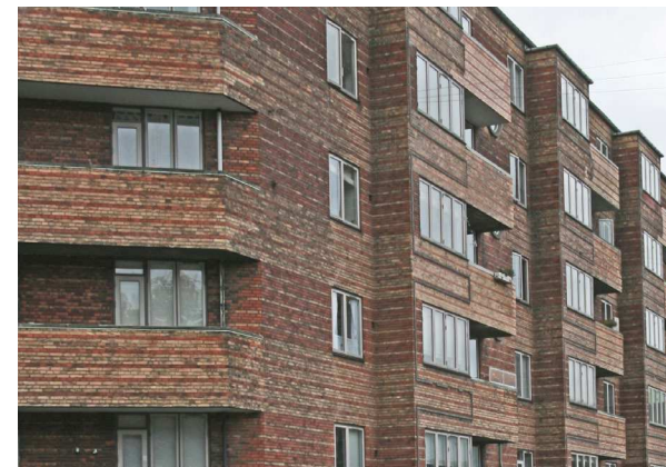
Sankt Kjeldes Plads. Oprindelige murede altaner der følger vinduesbåndene som et centralt motiv på facaden.
