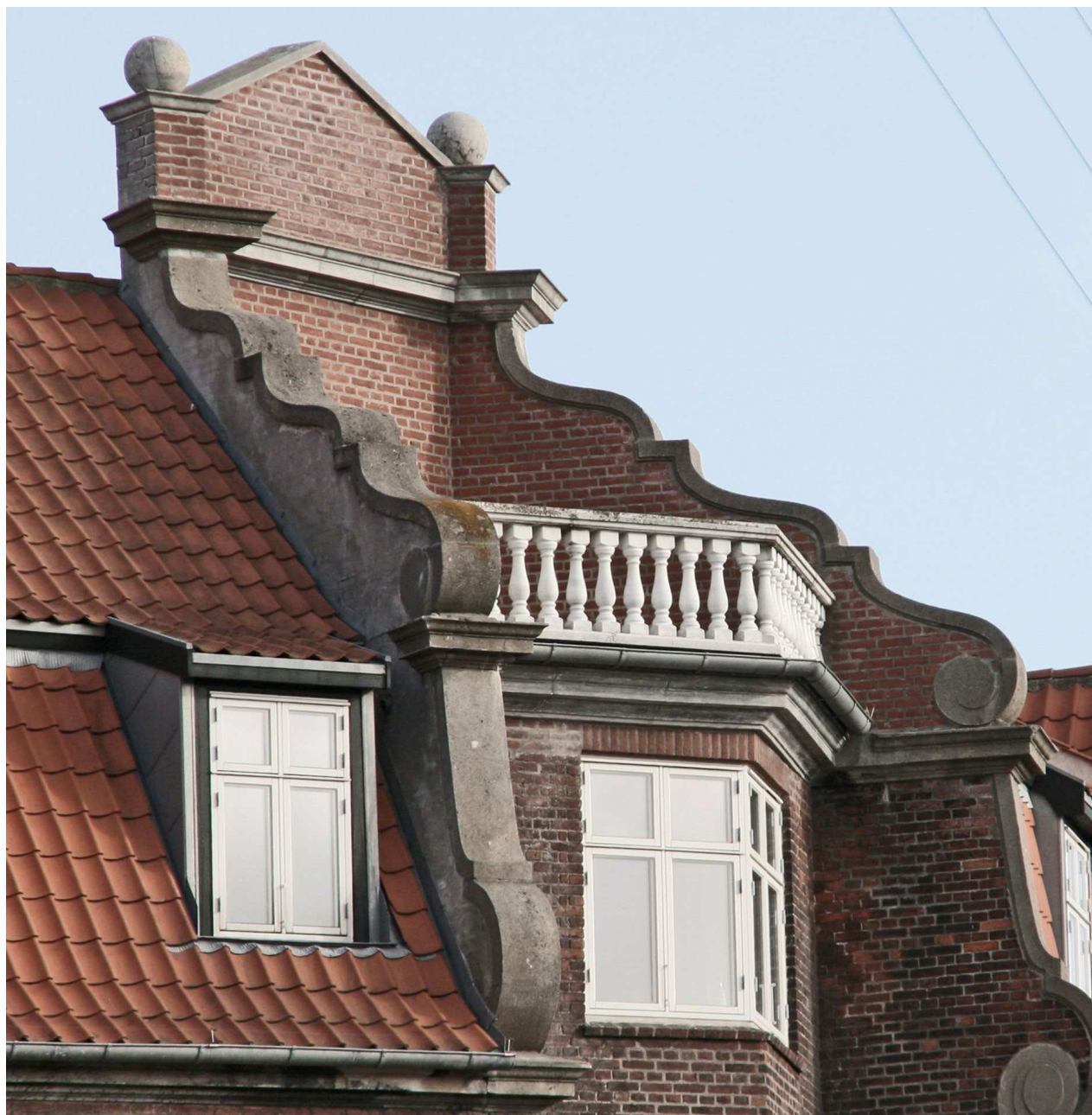
Snorregade. Oprindelig tagterrasse i mansardtag.
