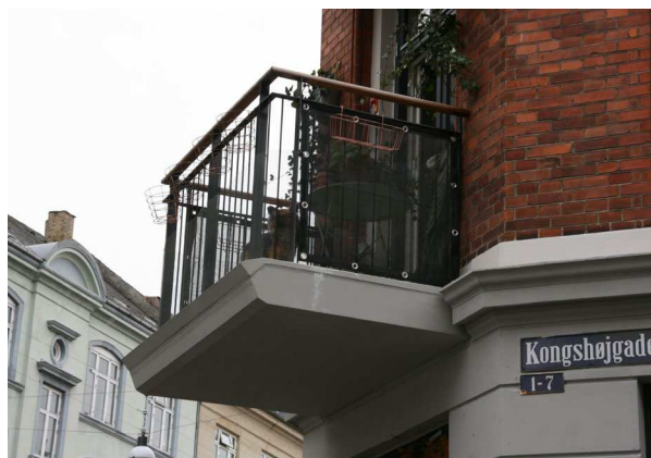
Kongshøjgade. Altanen bryder gesimsen men altanbundens materiale og udformning er tilpasset.
