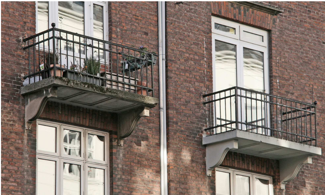
Sommerstedgade. Restaureret oprindelig altan.
