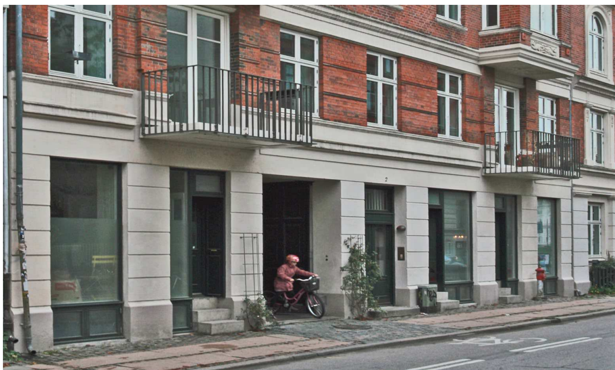
Sankt Hans Gade. Gesimsen er blevet brudt og de nye altaner har skåret sig ned i basen, men de tilpassede altanbunde og de enkle, spinkle værn gør, at der skabes en god helhedsvirkning.
