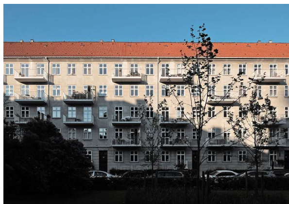
Humlebækgade. Altanerne er sat op efter et fast system der kan aflæses selvom alle ikke har fået altan.
