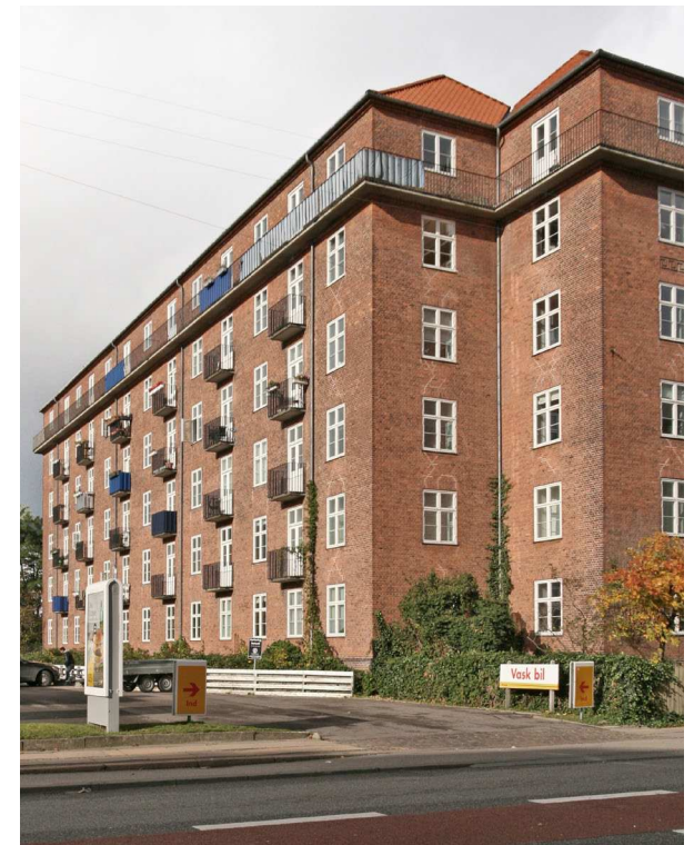
Amager Fælledvej. Forskellige altaner på den samme bygning.
