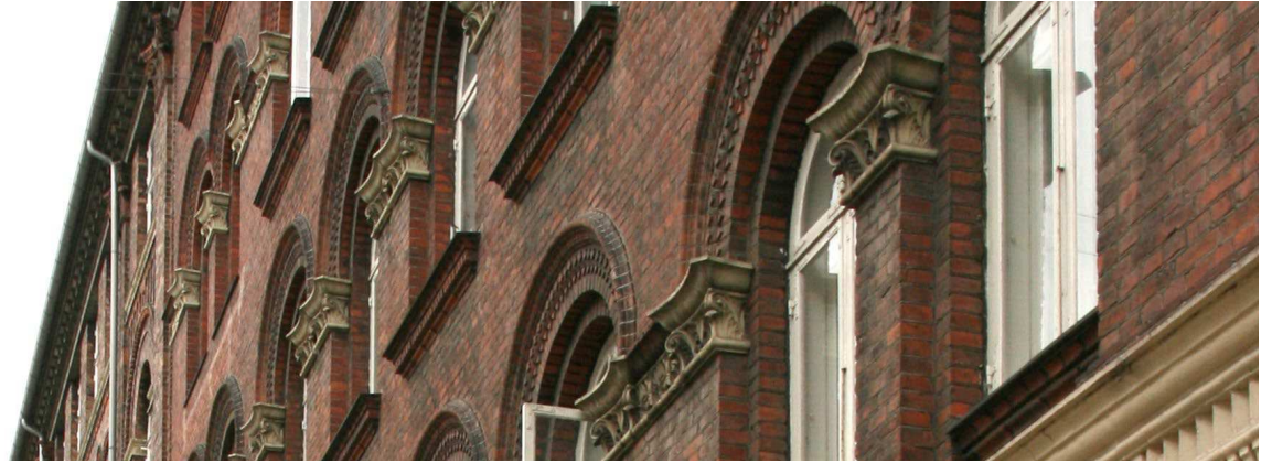
Holbergsgade. Detaljerig muret facade med rundbuer
