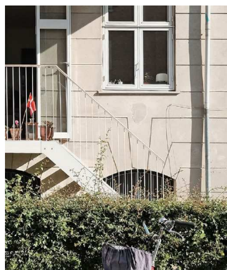
Trappe mod gaden etableret parallelt med facaden.
