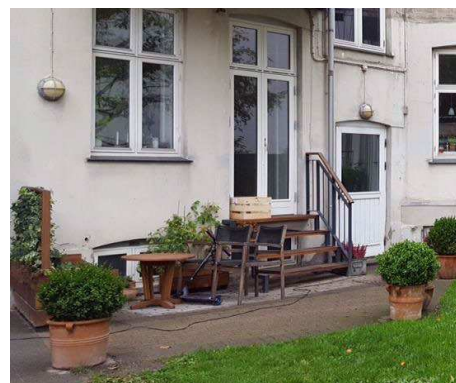
Trappe til terræn etableret vinkelret på facaden.
