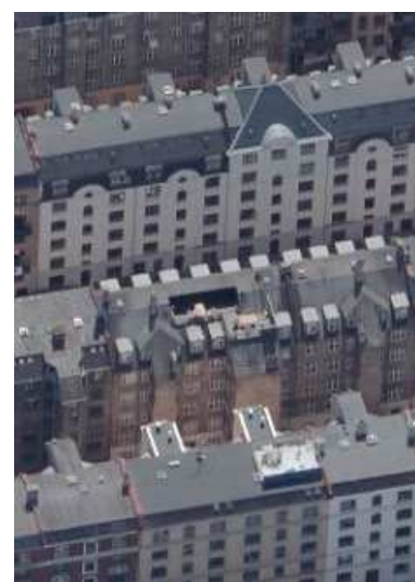
Ældre bygninger med trappetårne, der tager udsyn og dagslys.
