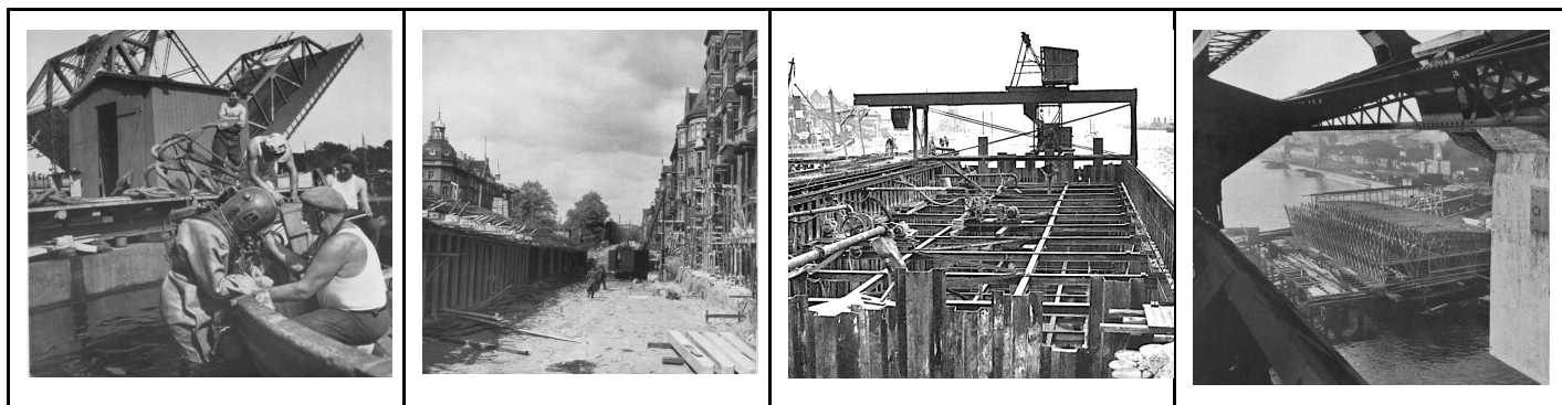
Ovenfor ses dykkere, der skal ned og undersøge havbunden inden broen bygges samt billeder fra byggeriet af nuværende Langebro.
