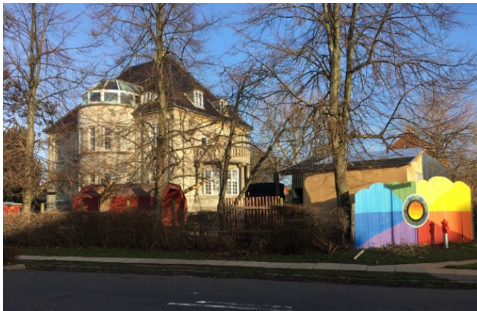
Lindholmsvej 18 set fra Højstrupvej.
