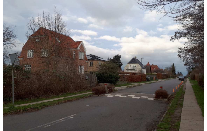
Højstrupvej set mod nordvest.
