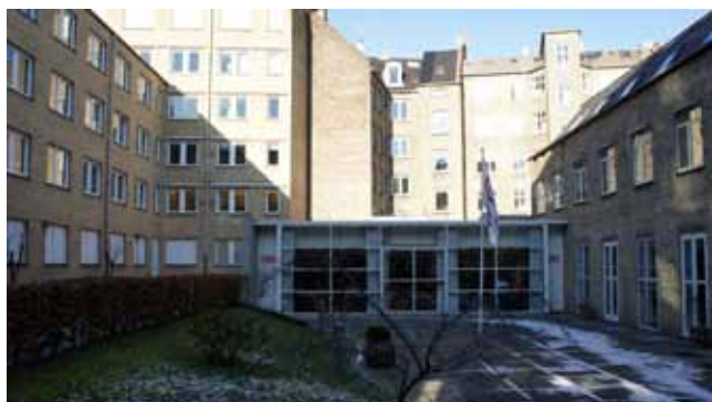
Den eksisterende kantine for Kræftens Bekæmpelse. I baggrunden ses bagsiden af randbebyggelsen mod Nordre Frihavnsgade.
