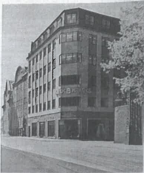
Sven Risom: Forretningsbygning paa Nørregade
