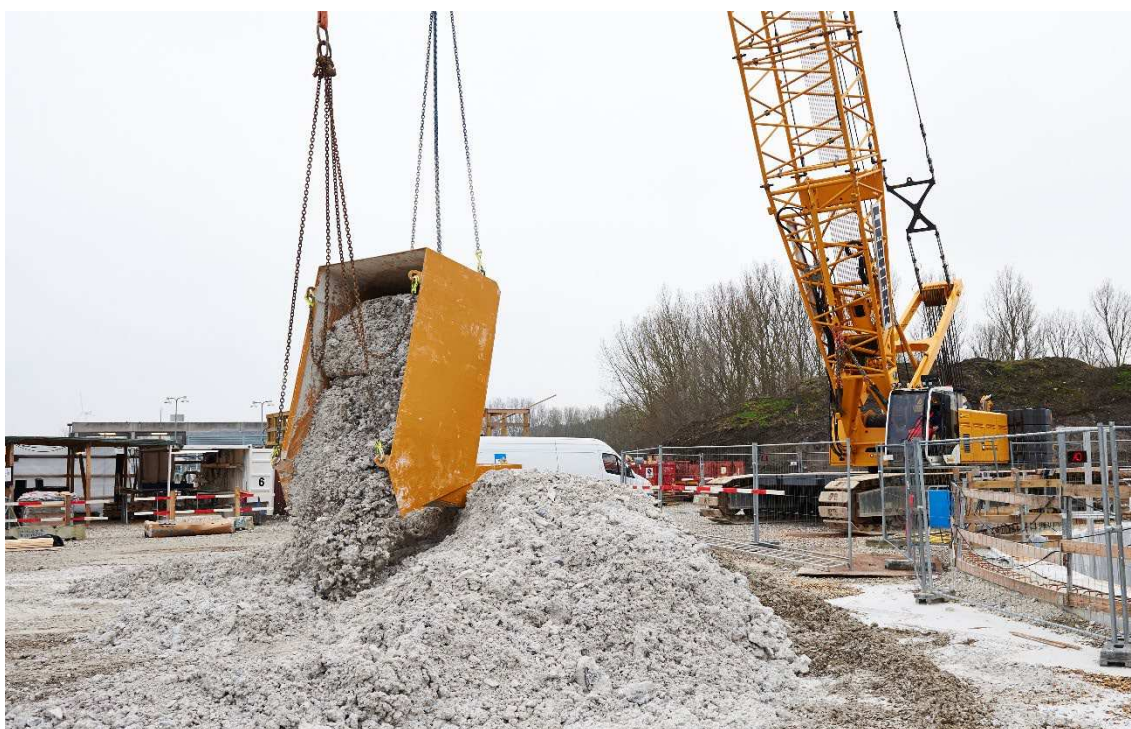
Figur 5.10: Tunnelmuck hejses op fra skakten til bortkørsel.
