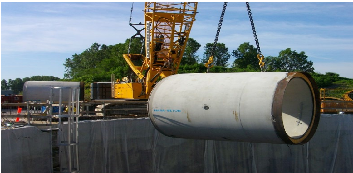
Figur 5.13: Tunnelrør nedsænkes i skakten.
