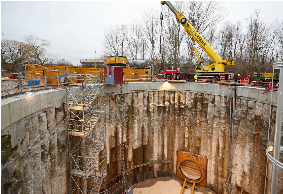
Figur 5.8: Skakt udført med sekantpælevæg
