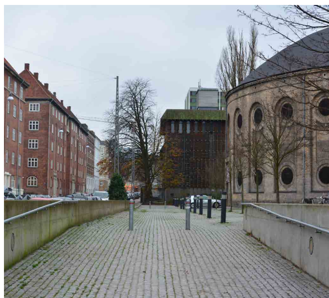
Nyborggade med Østre Gasværksteatret og Dongs Energikoblingsstation
