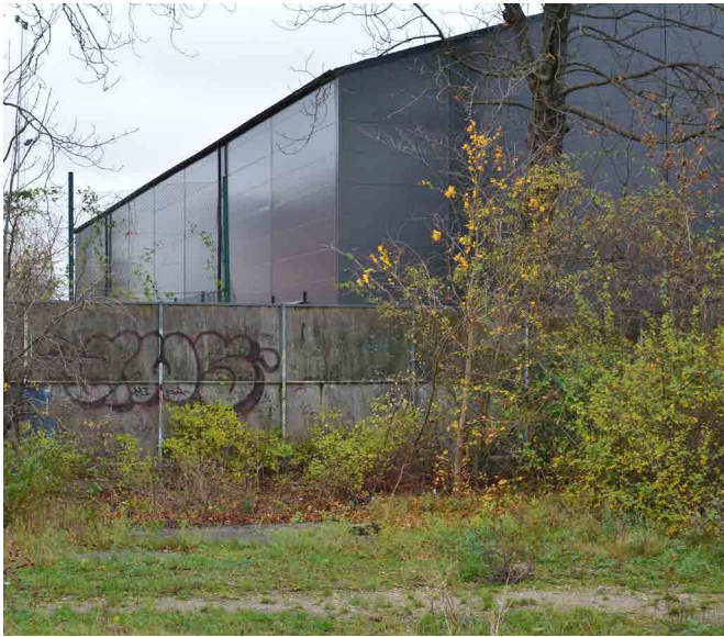
Tennishal ved områdets nordlige afgrænsning
