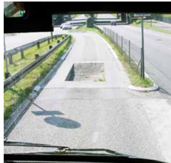
Busluse med grav og opkørselsrampe på Avedøre Havnevej ved Rødovre station
