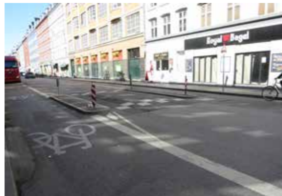
Vejbump på Rantzausgade har skabt lokal utryghed
