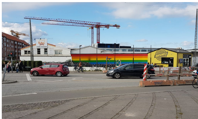
Bygningerne på hjørnet af Skelbækgade og Ingerslevsgade herunder bygning 7 og 8, Kødboerne 16-18 og Kødboerne 2-14, vil kunne nedrives i forbindelse med nyt skolebyggeri på grunden. Lokalplanen muliggør nedrivning. Øvrige bygninger inden for område IV vil også kunne nedrives.
