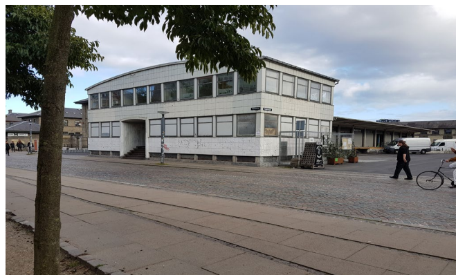
Bygning 29, Halmtorvet 15, der vil kunne nedrives i forbindelse med nyt erhvervsbyggeri på grunden. Der er ikke aktuelle byggeplaner. Nedrivning kræver lokalplantillæg. Bagbygningen langs Slagtehusgade vil også kunne nedrives.
