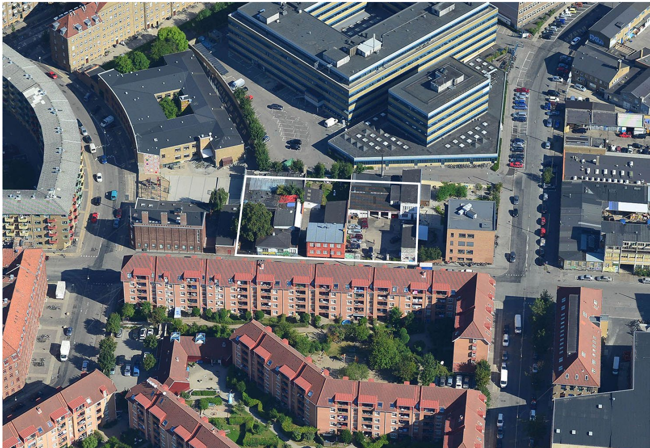
Luftfoto af lokalplanområdet og dets omgivelser set mod nord, 2012. Lokalplanområdet ligger i et kvarter med forskelligartede bygningstypologier indeholdende primært småerhverv, boliger og uddannelsesinstitutioner.
