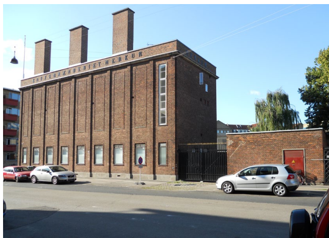
Denne treetagers fredede bygning rummede oprindeligt et kaffebrønderi. (Foto: Københavns Kommune)
