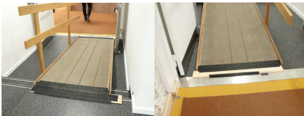
Ramper fra gang til selve valglokale med afsluttende udbedring udført samme dag
