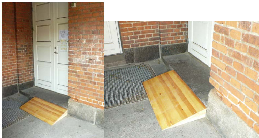
Rampe udført samme dag til afhjælpning af konkret tilgængelighedsproblematik
