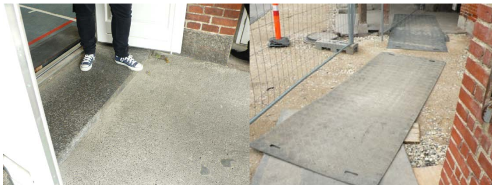
Trin samt underlag ved udgang fra valglokalet
