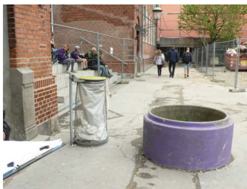
Adgangsvej til valglokale via skolegård under renovering
