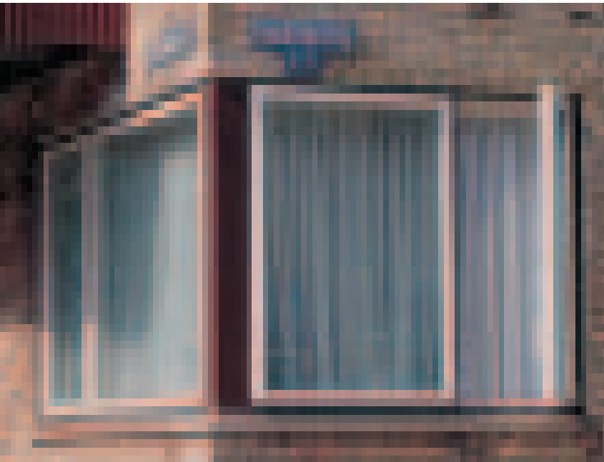
Udskiftningen til termovinduer med rammer i træ og aluminium har bevaret rammens oprindelige dimensioner, Statholdervej 1-11.
