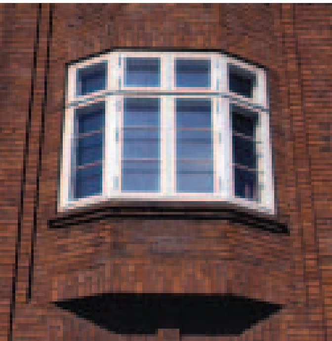
Karnap, hvor murværks detaljerne er bevaret, Ingerslevsgade.
