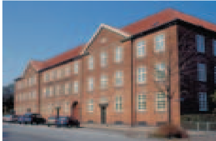
Denne bebyggelse fra 1920'erne har fået udskiftet vinduerne til nye vinduer med enkelt lag glas, sprosser og kitfals i yderste ramme, og med en fortsatsrude med thermoglas indvendigt, Hvidkildevej/Hulgårdsvej.
